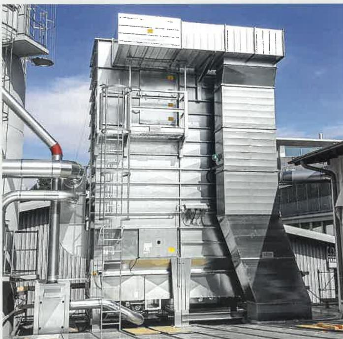
Der beeindruckende Filterturm weist eine Absaugleistung von 36 000 m<sup>3</sup>/h auf.
